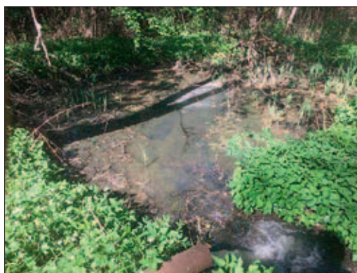
Рис. 1. До установки мобильного очистного сооружения (Милохово, Смоленская область)
